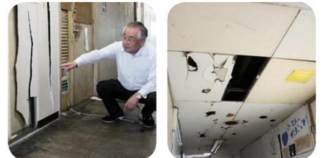
左：破れたまま修繕が放置された部室の壁 右：老朽化で天井板が落ちて大小の穴が開いた通路の天井
